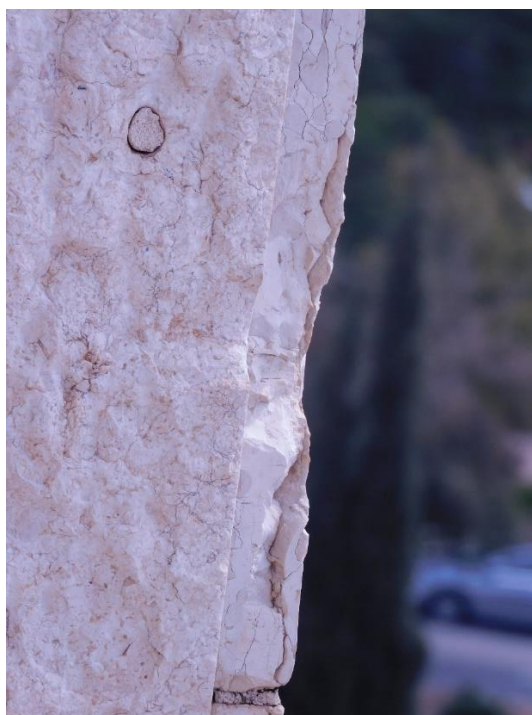
איור 49 - ח. דרומית ק-6 - מילוי בראש הבורג על סף נשירה + לוח אבן בניצב סדוק התפרק ונשר חלקית
