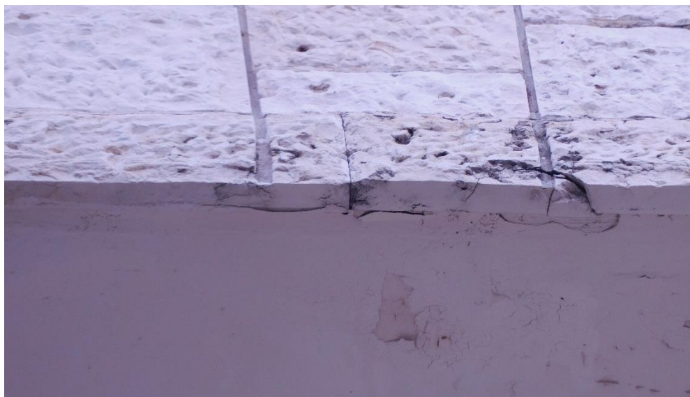
איור 33 - ח.מזרחית - מקטע דרומי-מרפסת ק-6 - לוחות אבן שבורים על סף נשירה
