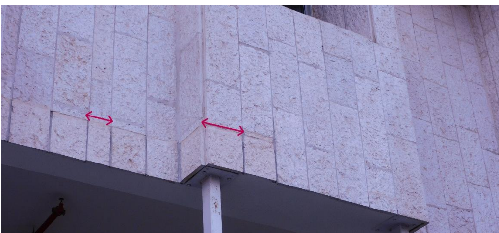
איור 12- דוגמא למלאכות שונות - הוספת קיבוע מכני בלוחות אבן "קטנים" / "צרים"
