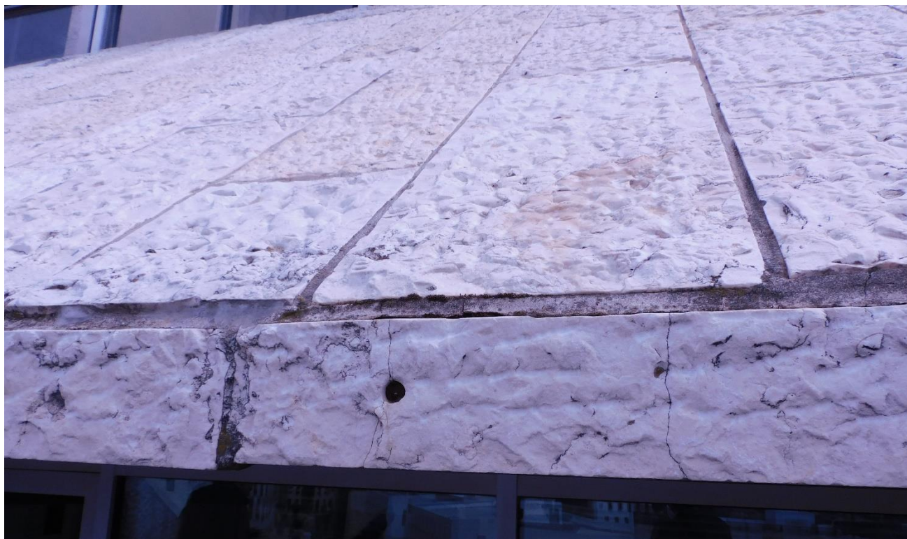
איור 13 - דוגמא למלאכות שונות - החלפת לוח אבן וחידוש מילוי מישק כוחלה
