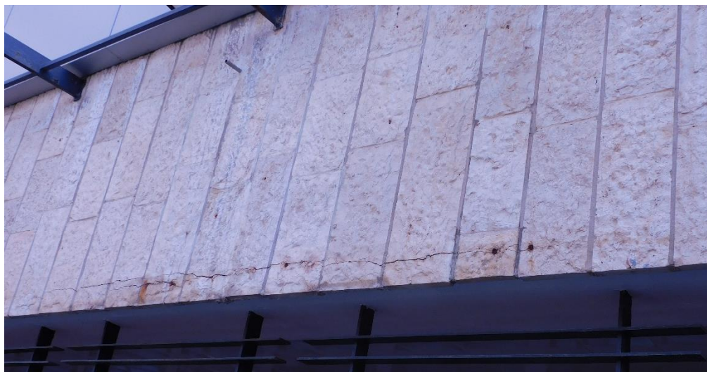
איור 36 - ח. דרומית - מקטע מזרחי - ק-1 - סדק אופקי בלוחות אבן בשורה ראשונה מעל הפתח
