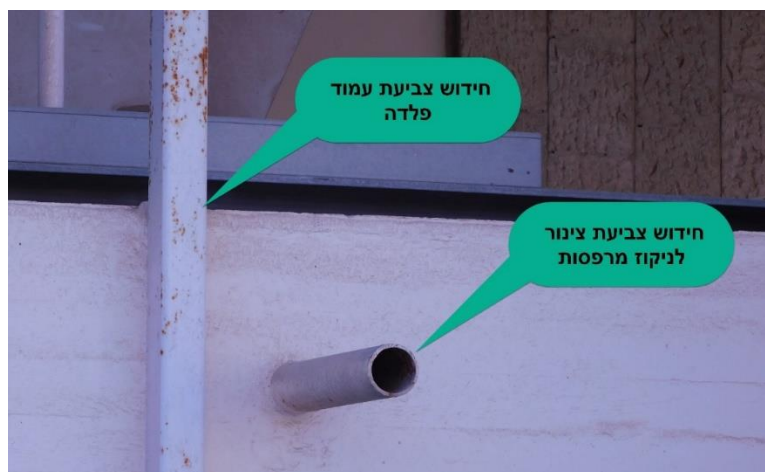
איור 26 - ח. צפון - מבט מקרוב על חידוש צביעת רכיבי פלדה
