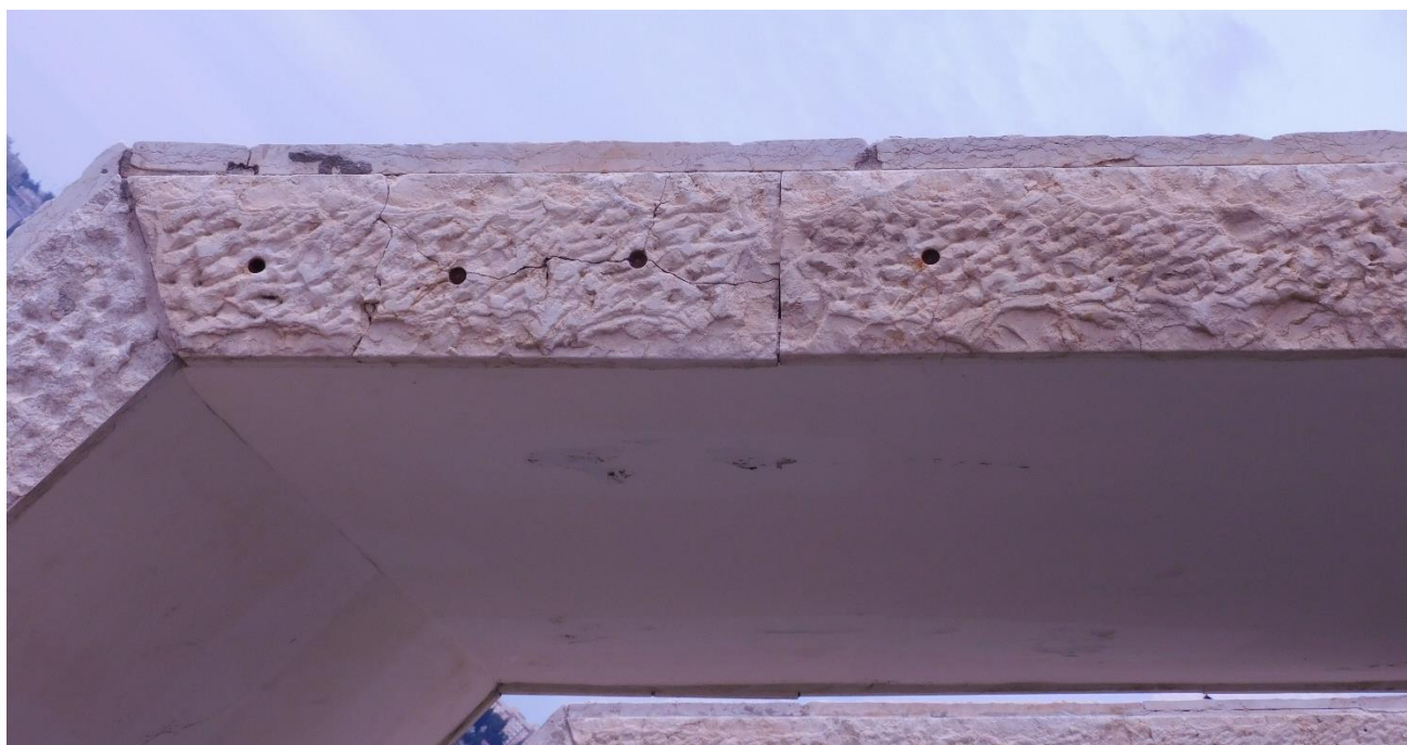
איור 14 - דוגמא למלאכות שונות - החלפת לוח אבן וחידוש מילוי מישק
