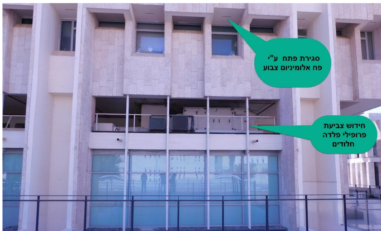
איור 24 - ח. צפון - סגירת פתח וחידוש צביעת רכיבי פלדה
