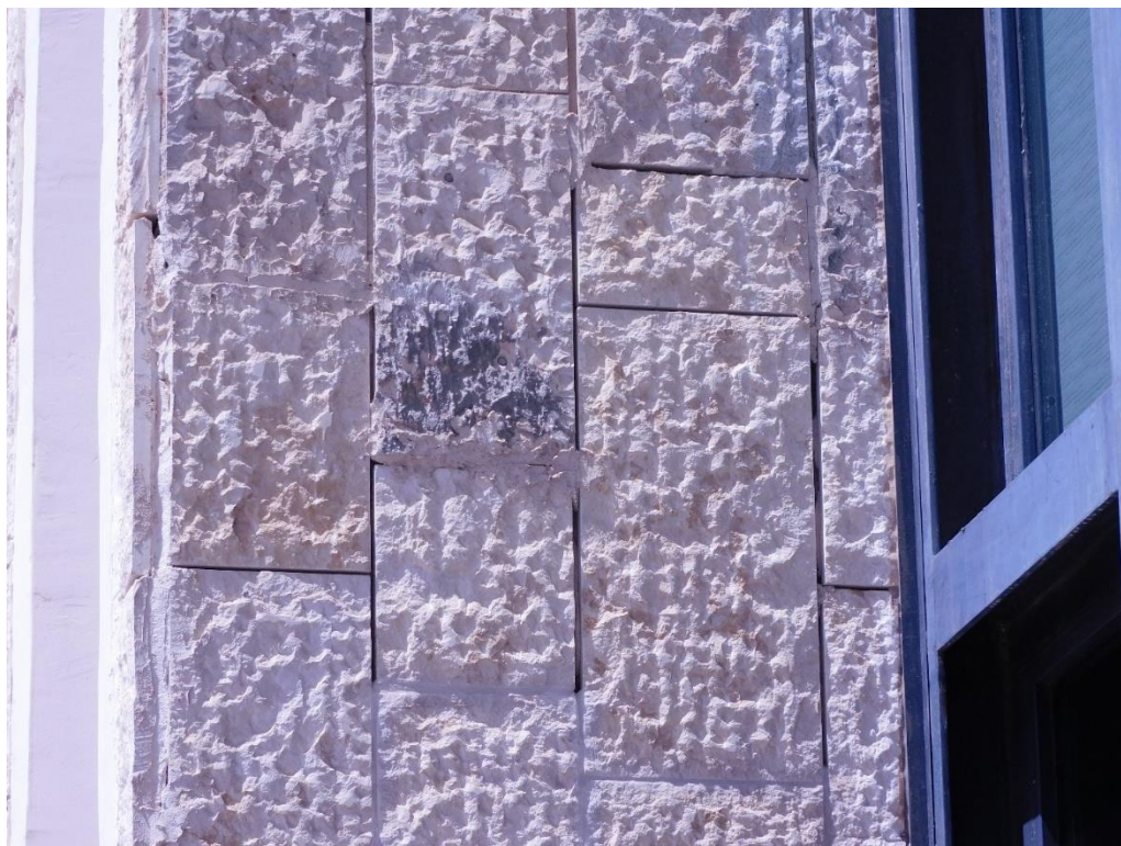
איור 19 – ח. דרום מקטע מזרח – לוחות אבן אשר הוחלפו במהלך שיפוץ פנים - יש למלא מישקים (בחלקם יושם דבק שיש להסירו) להוסיף קיבוע מכני באבן, להסיר שכבות משקע, צמנט, דבק וכו' מפני האבן
