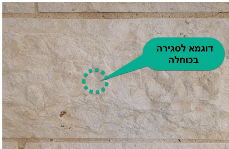
איור 7 - דוגמא לתוצאה רצויה - סגירת ראש בורג בכוחלה
