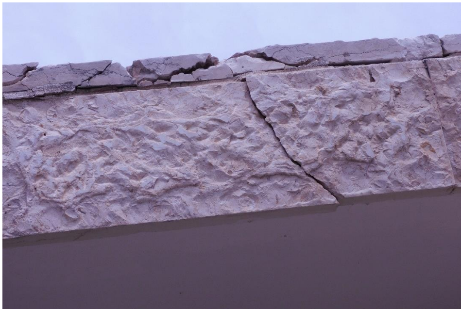
איור 15- דוגמא למלאכות שונות - החלפת לוח אבן וחידוש מילוי מישק
