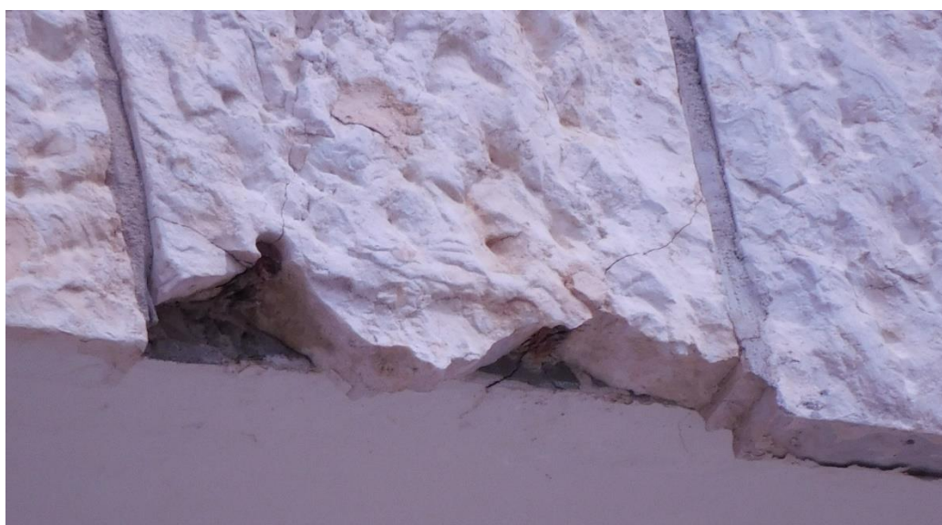
איור 35 - ח. דרומית - מקטע מזרחי - ק-4 - סדקים רדיאליים במיקום העיגון החלוד, חלק מהאבן נשר
