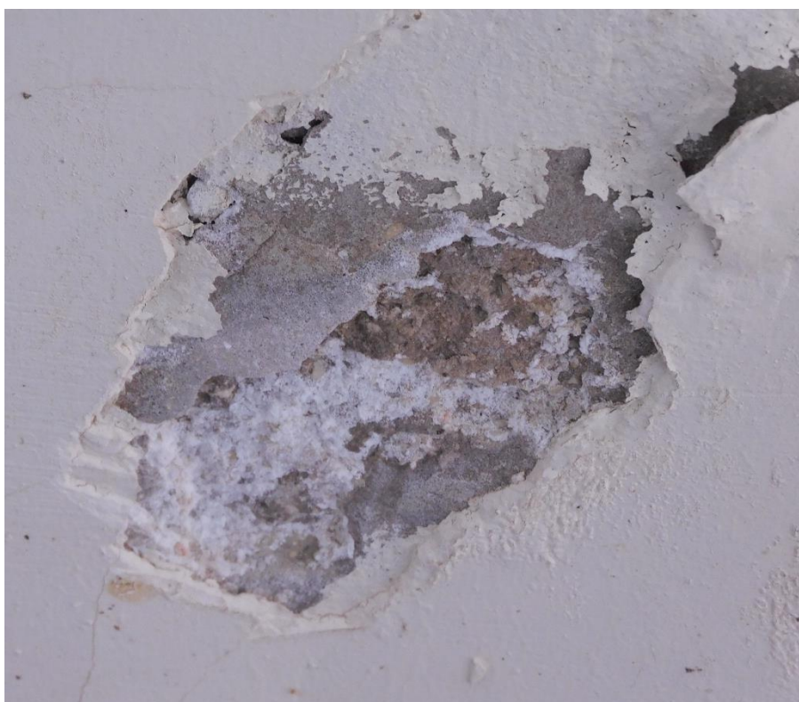
איור 45 - ח. דרומית ק-6 גב קיר המחופה אבן ובצידו ההופכי מצופה טיח - עובש לבן בטיח
