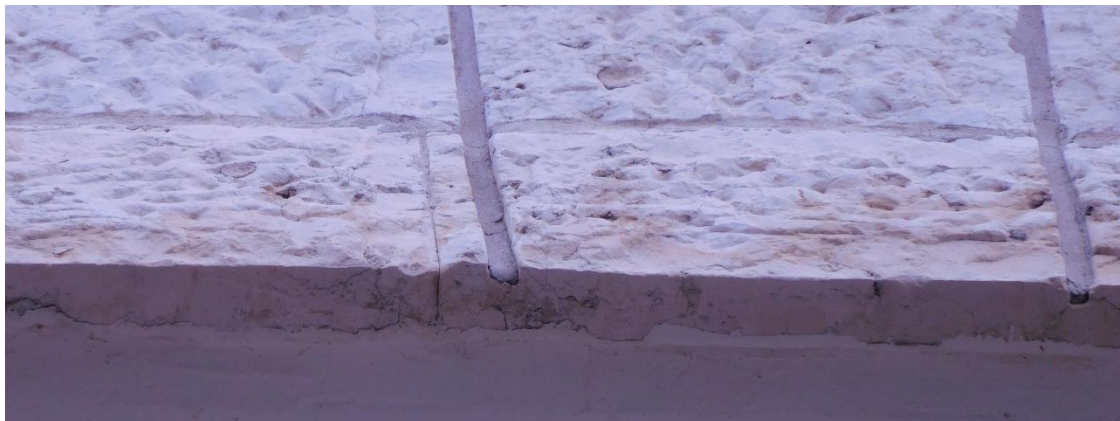
איור 38 - ח. מערבית - מקטע דרומי-ק-6 לוח אבן נוסר ונסדק
